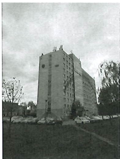
Widok obiektu wraz z zainstalowanym zespołem antenowym
