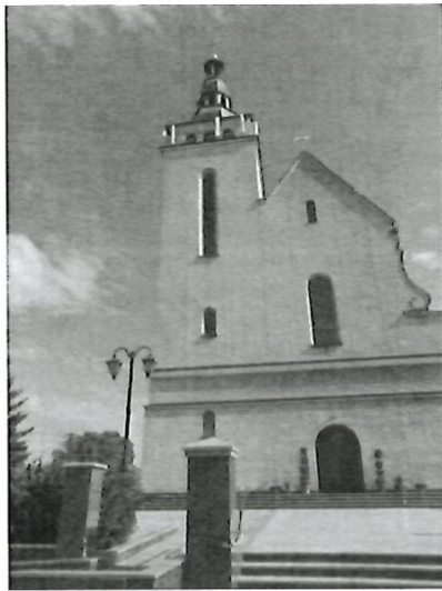
Widok obiektu wraz z zainstalowanym zespołem antenowym
