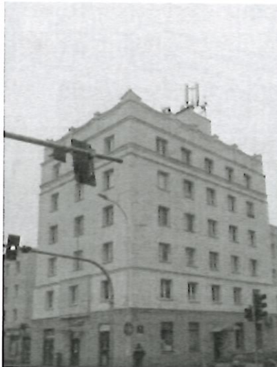
Widok obiektu wraz z zainstalowanym zespołem antenowym
