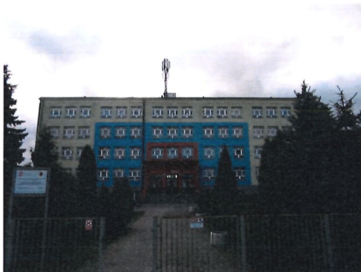
Zał. nr 1: Widok ogólny instalacji radiokomunikacyjnej.
