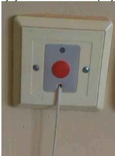
Istniejące przyciski przyzywowe sznurkowe z przyciskiem – do wymiany
